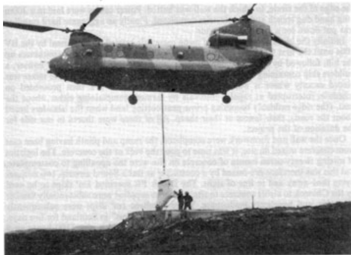
Photo 1. Pouring concrete.
